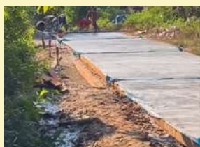
Pembangunan Rabat Beton Dusun II
